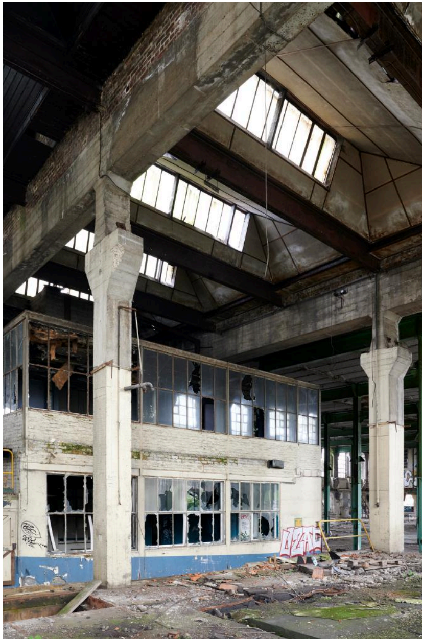
Cabine de commande installée dans l'ancienne salle des machines.
