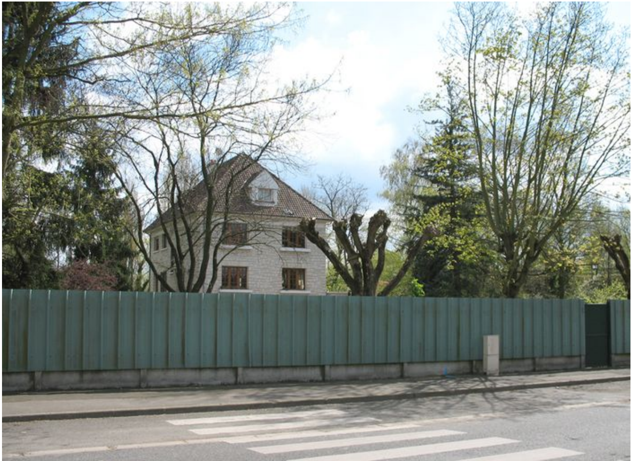
Vue générale de l'une des maisons d'ingénieurs au milieu de son parc arboré.
