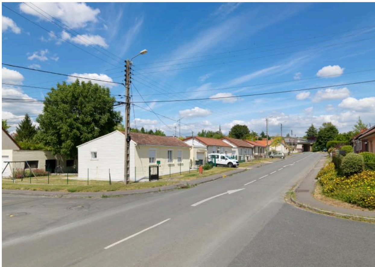
Rue de Cachy, vue depuis le sud.
