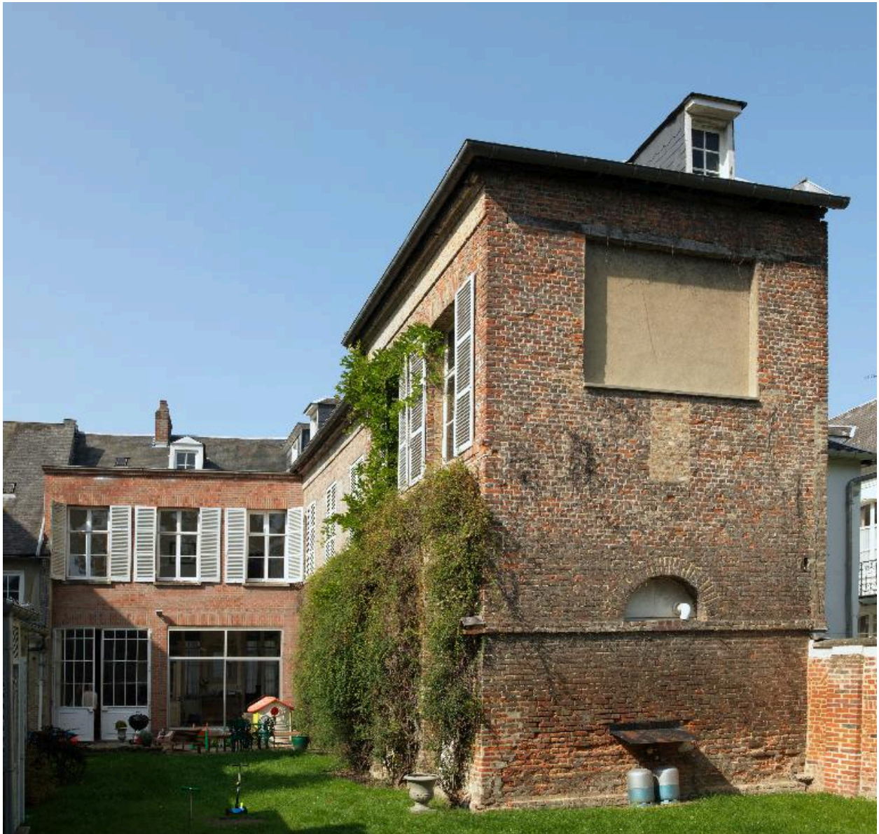
Façades sur jardin.
