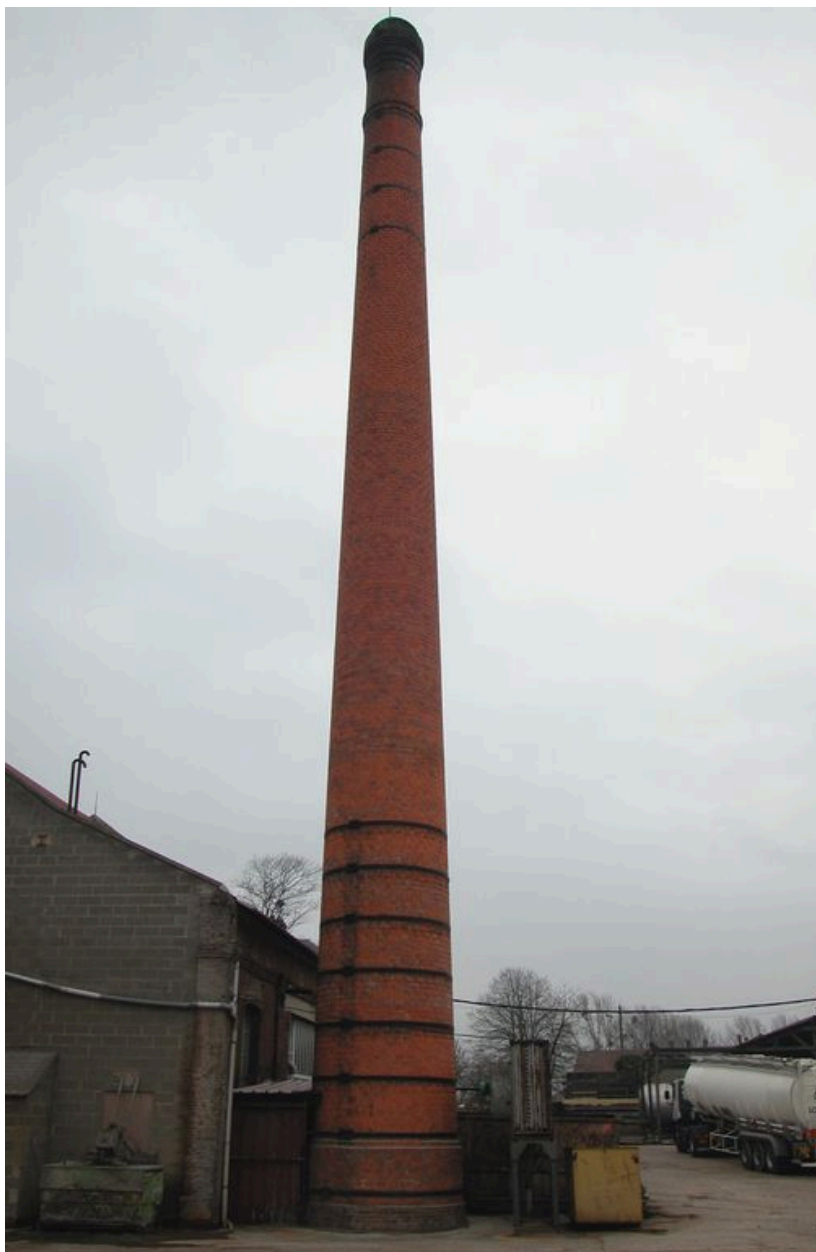
La cheminée de l'usine, vue d'ensemble.
