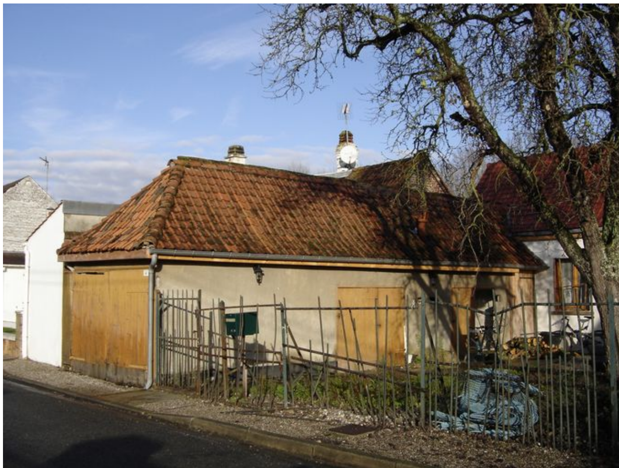
Vue de l'ancienne grange.
