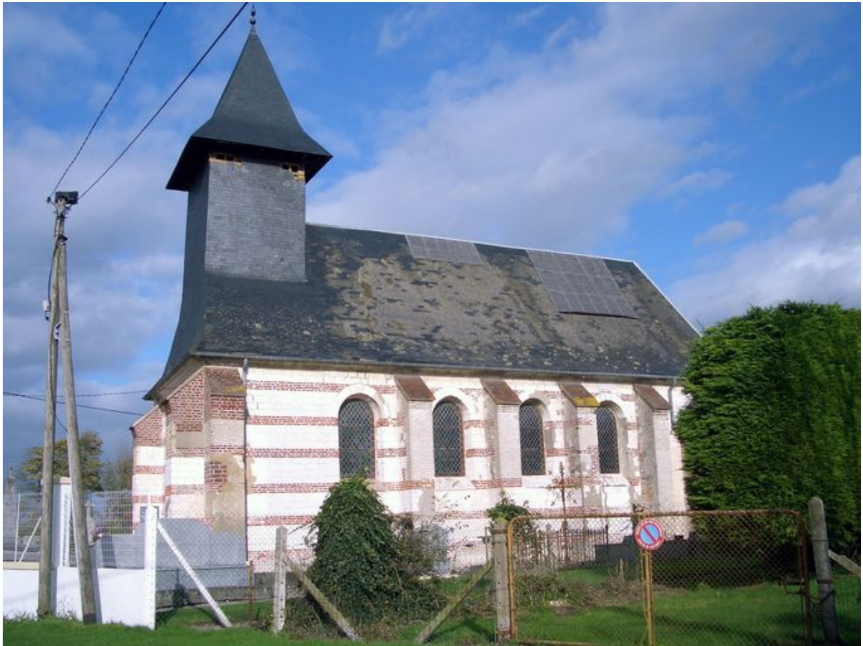
Vue depuis le sud.
