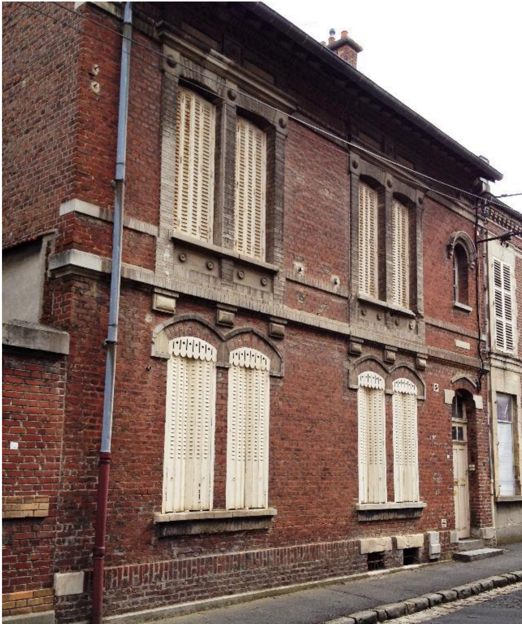
Logements d'instituteurs construits en 1900, sur les plans d'Emile Ricquier.
