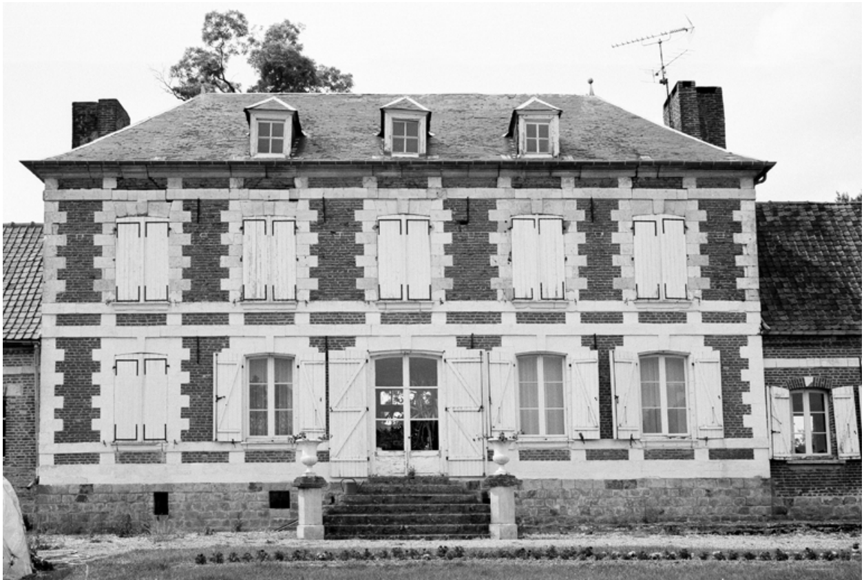
Flesselles, maison de notable, Olincourt.
