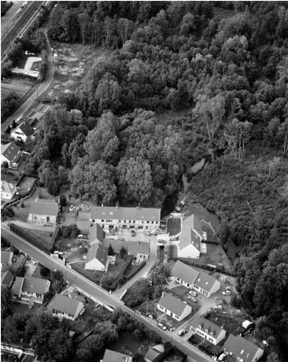
Vue aérienne du site de l'ancien moulin de la Commanderie prise vers le nord, 1993.
