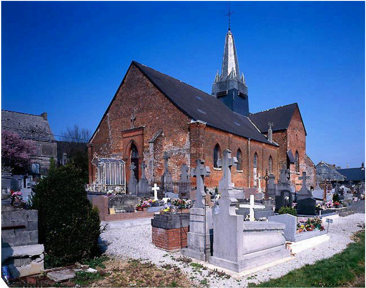
Vue générale depuis le sud-ouest.
