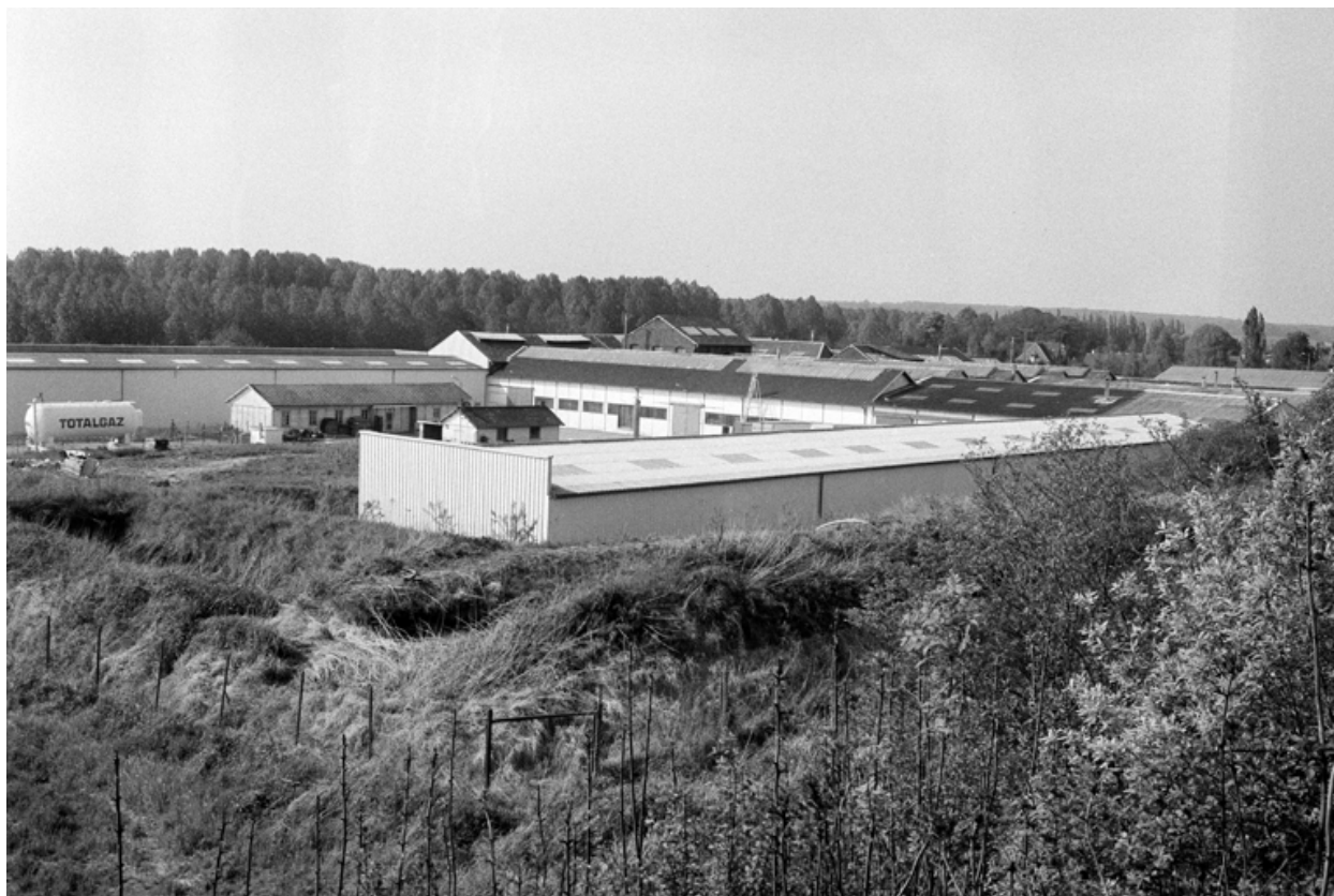
Anciens ateliers, vue partielle, flanc sud.
