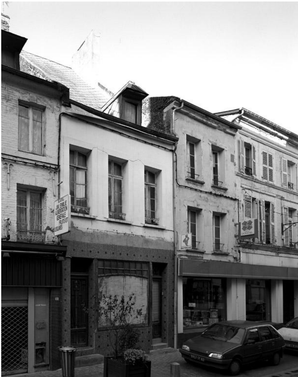
Vue de la façade sur rue.
