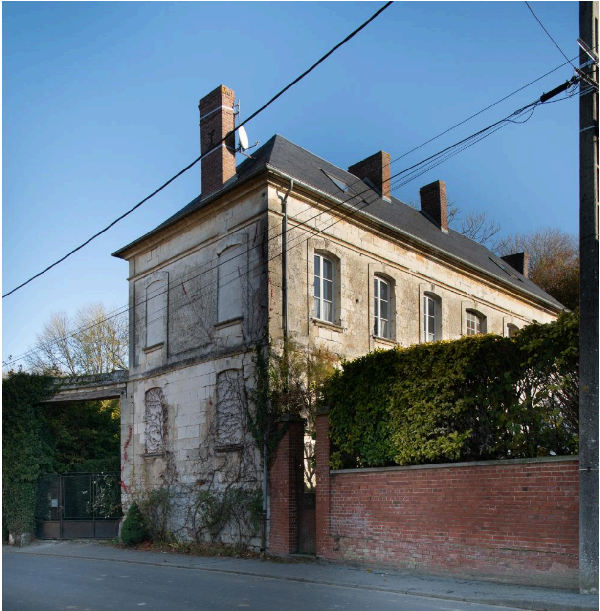
Ancienne demeure d'Henriette Lévêque (veuve Pigeon) dite la "dame des pauvres", 1729, n°34 rue d'Amiens, vue depuis le sud-ouest.
