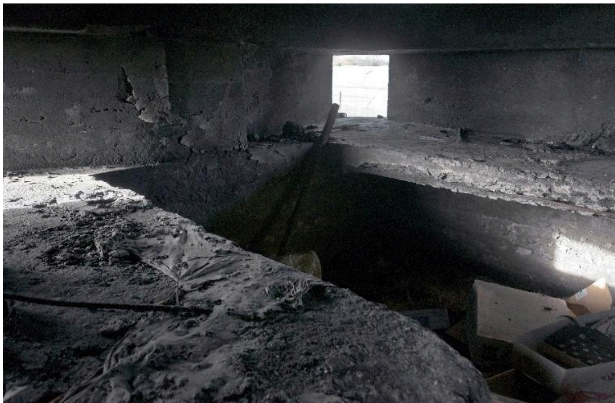
Vue intérieure des banquettes de tir nord et sud. Embrasure de tir nord-ouest
