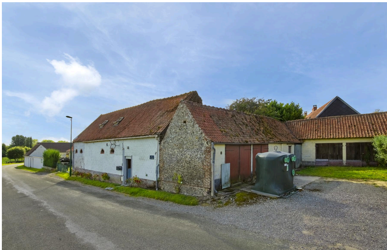
Ancienne ferme (1 rue de l'Église).
