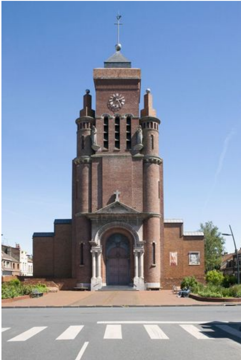
Élévation antérieure de l'église.
