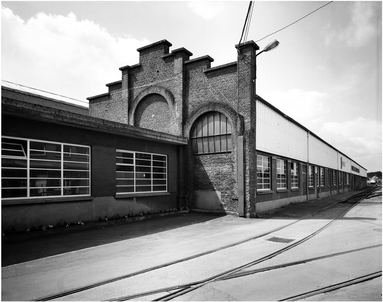
Vue générale du hall 10.
