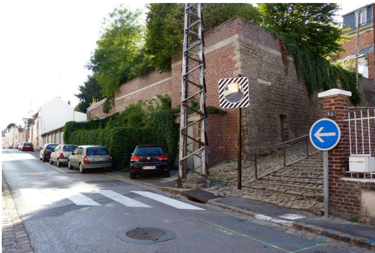
Vestiges de la première enceinte de Péronne, rue du Collège.
