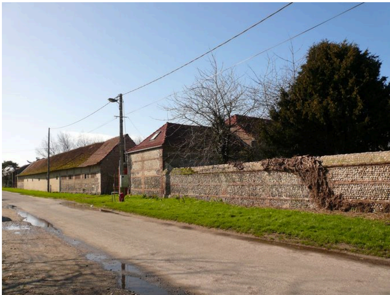
Vue générale extérieure depuis le nord.
