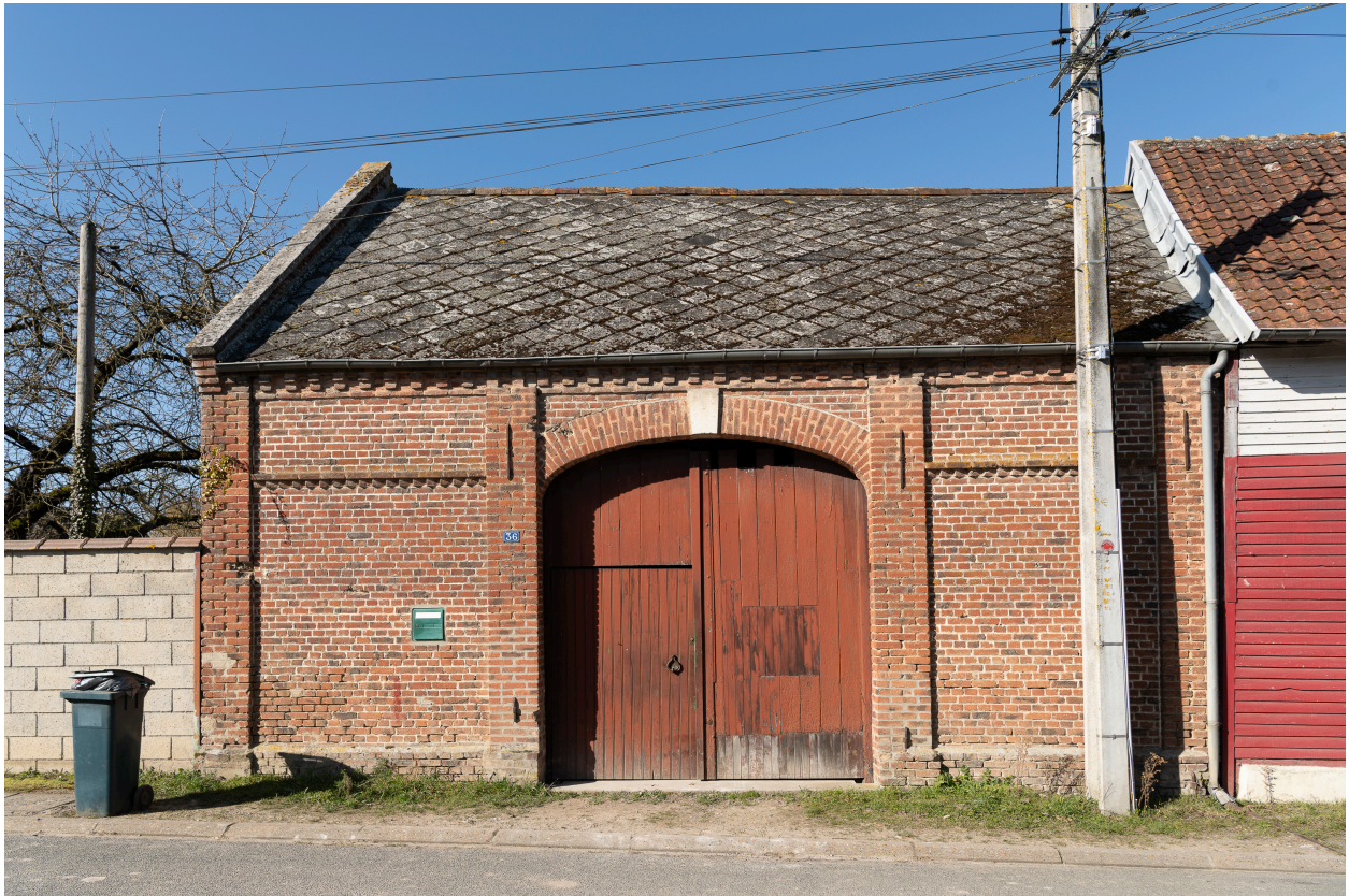
Grange sur rue, n°36 de la rue Yves-Maréchal, vue depuis l'est.
