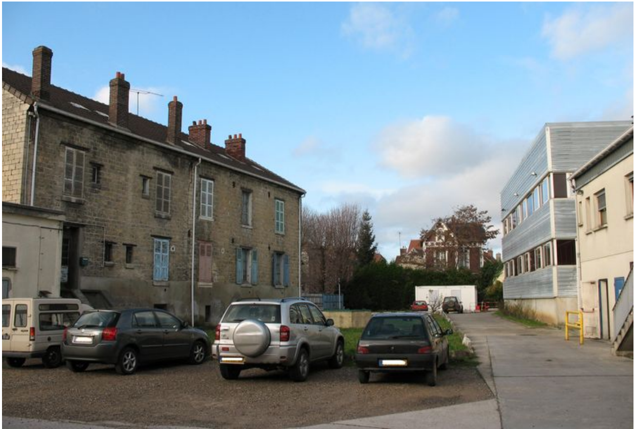
Cour intérieure de l'usine avec à gauche les logements d'ouvriers et au fond le logement du chef produits.
