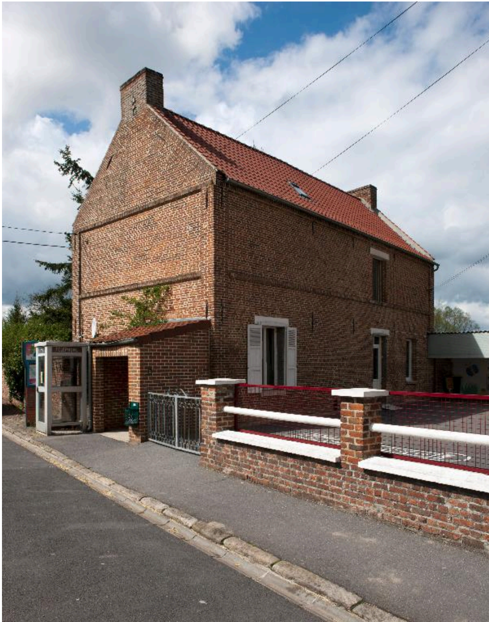
Vue générale de l'ancien logis, transformé en salle de classe.
