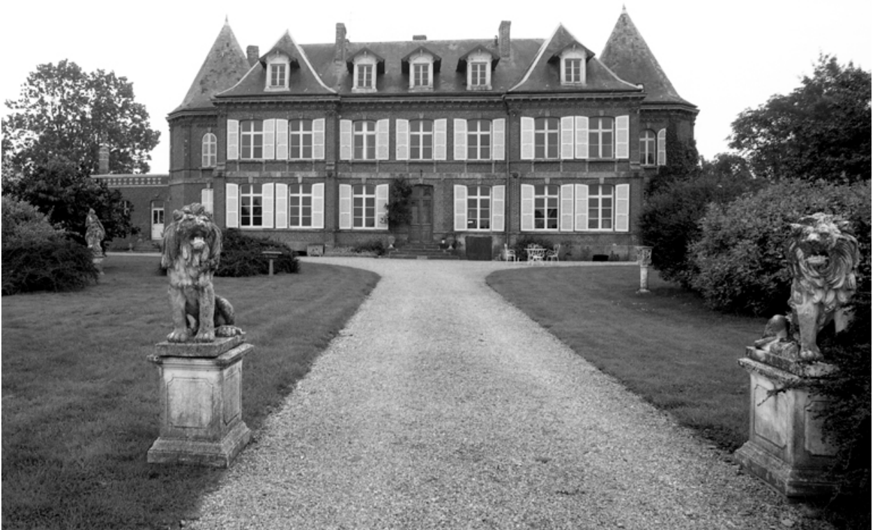
Vue d'ensemble de la façade du logis.
