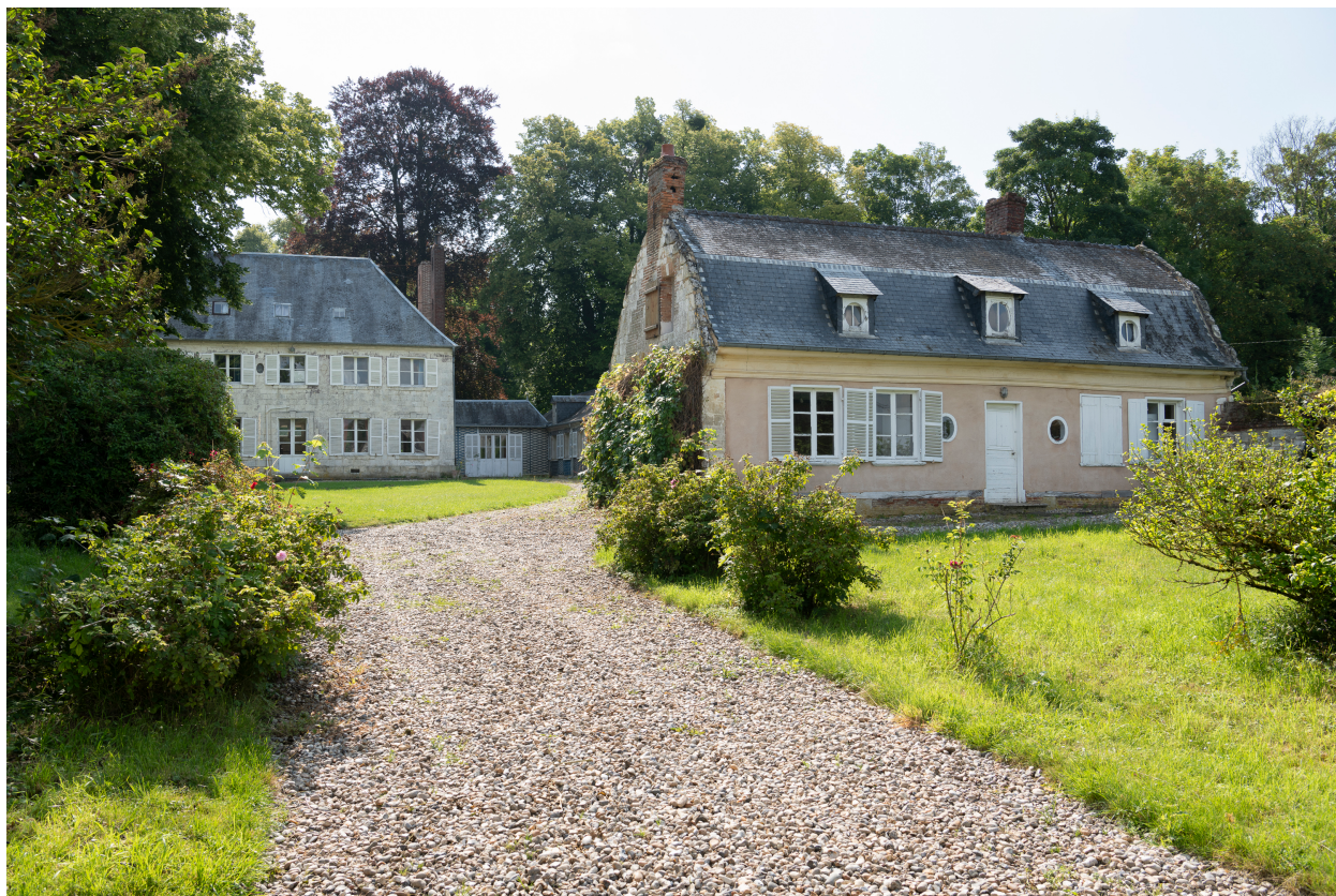
Ancien logement des domestiques et logis en arrière-plan, vue depuis l'ouest côté cour.
