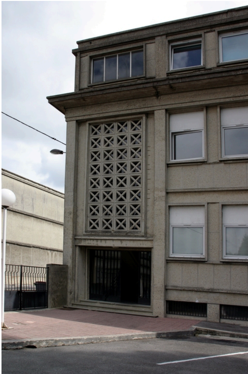
Détail de la façade des services sociaux.
