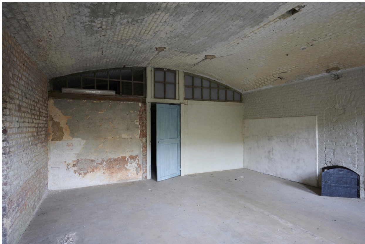
Sous-sol de caserne de gorge. Ancienne tisannerie.
