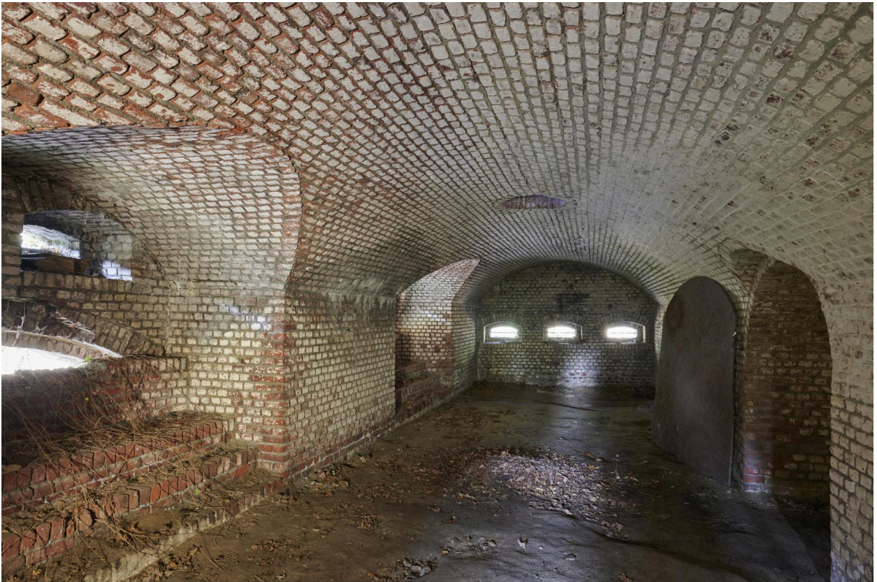
Aile ouest. Caponnière simple. Embrasures de tir et meurtrière à grenades (à gauche).
