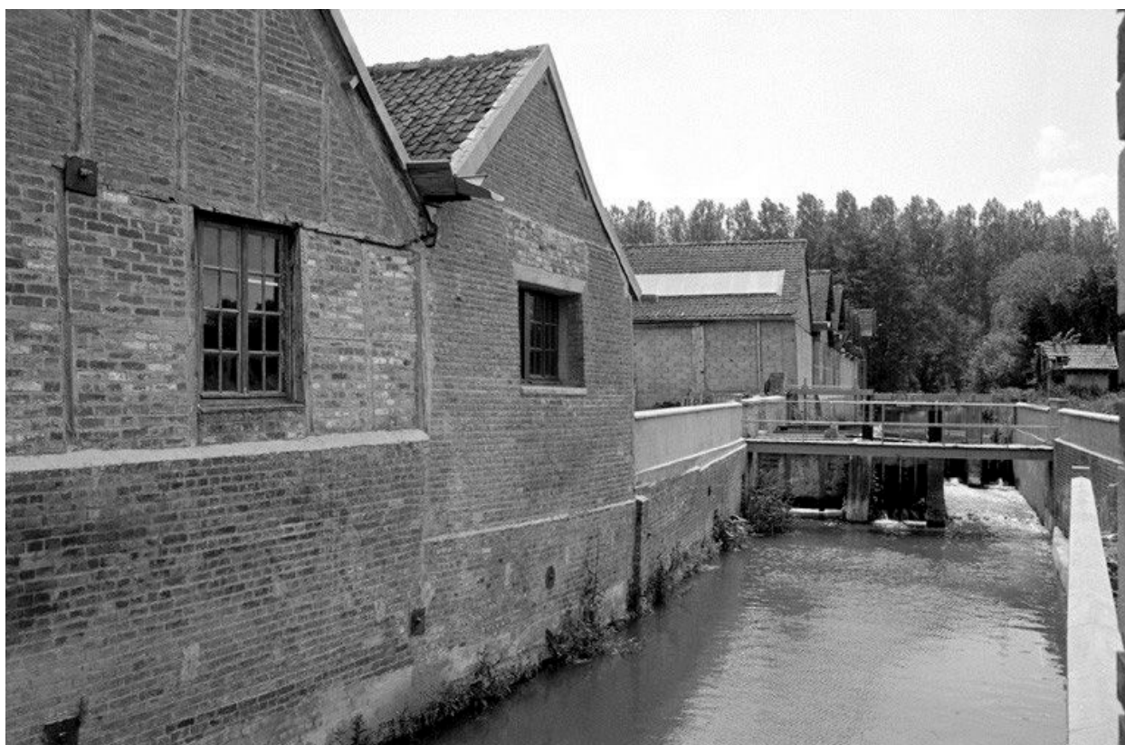
Ateliers de fabrication et voie d'eau, flanc ouest.
