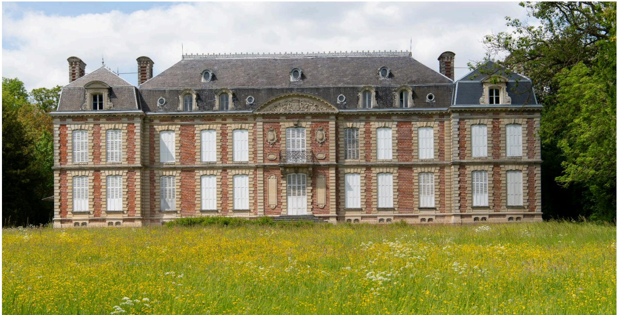
Vue générale du logis depuis le sud (côté cour).
