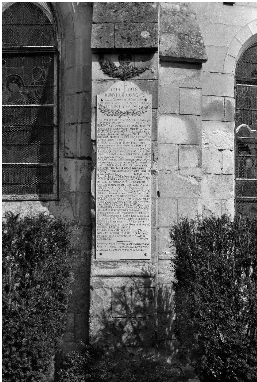
Plaque en marbre fixée à l'extérieur de l'église et faisant office de monument aux morts.
