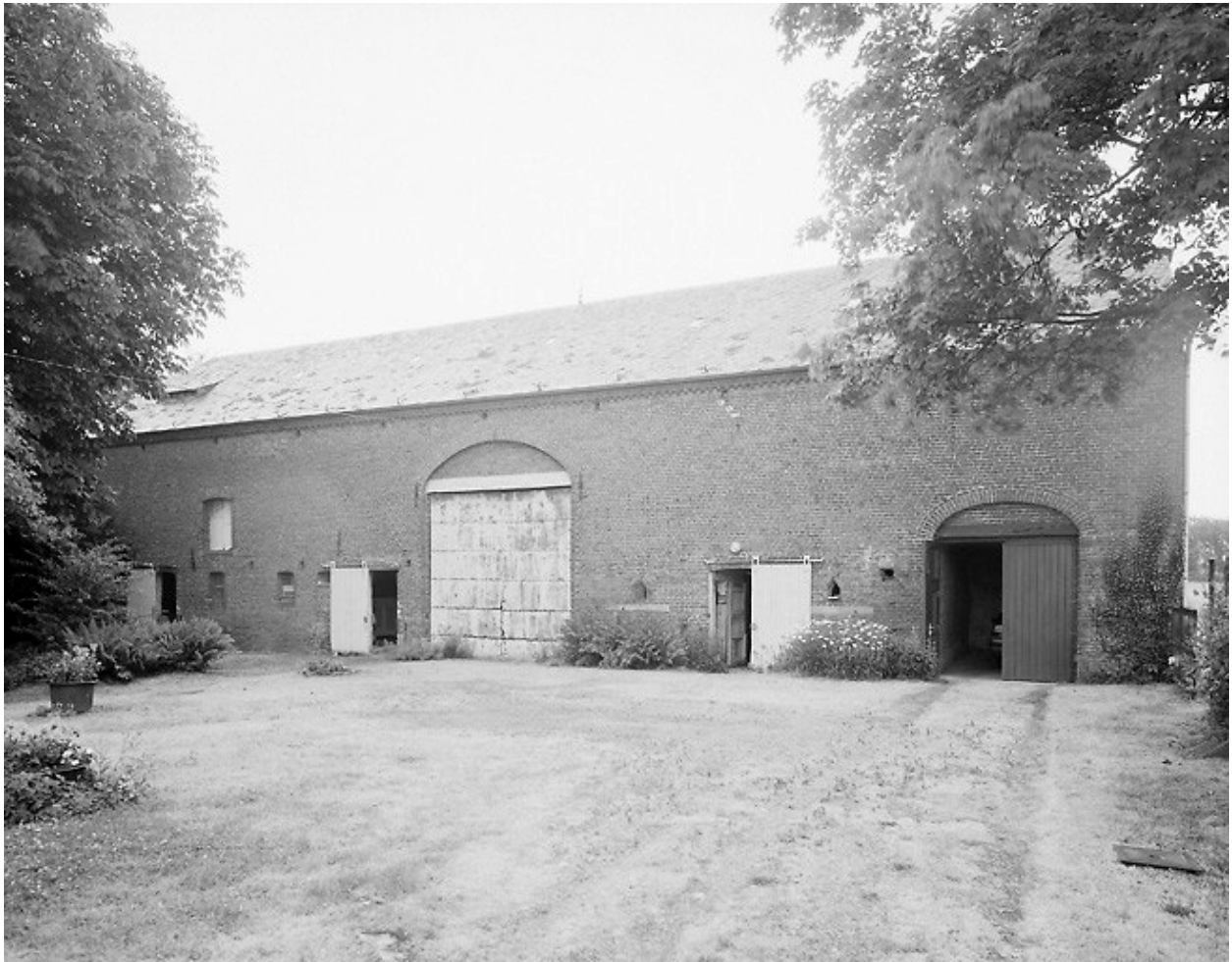
Vue générale de la grange, des étables et du fenil, depuis la cour.
