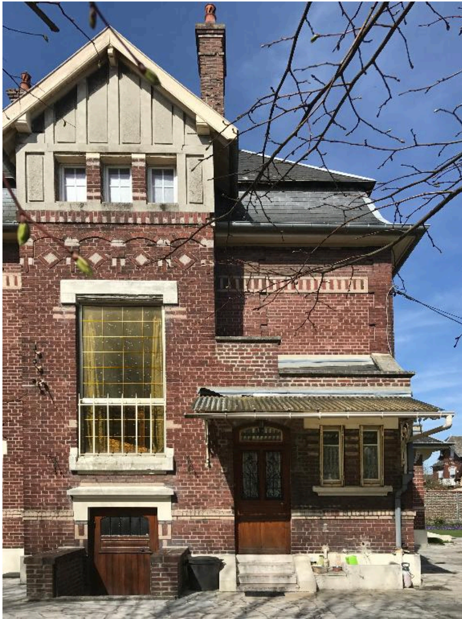
Façade latérale sud, vue partielle.
