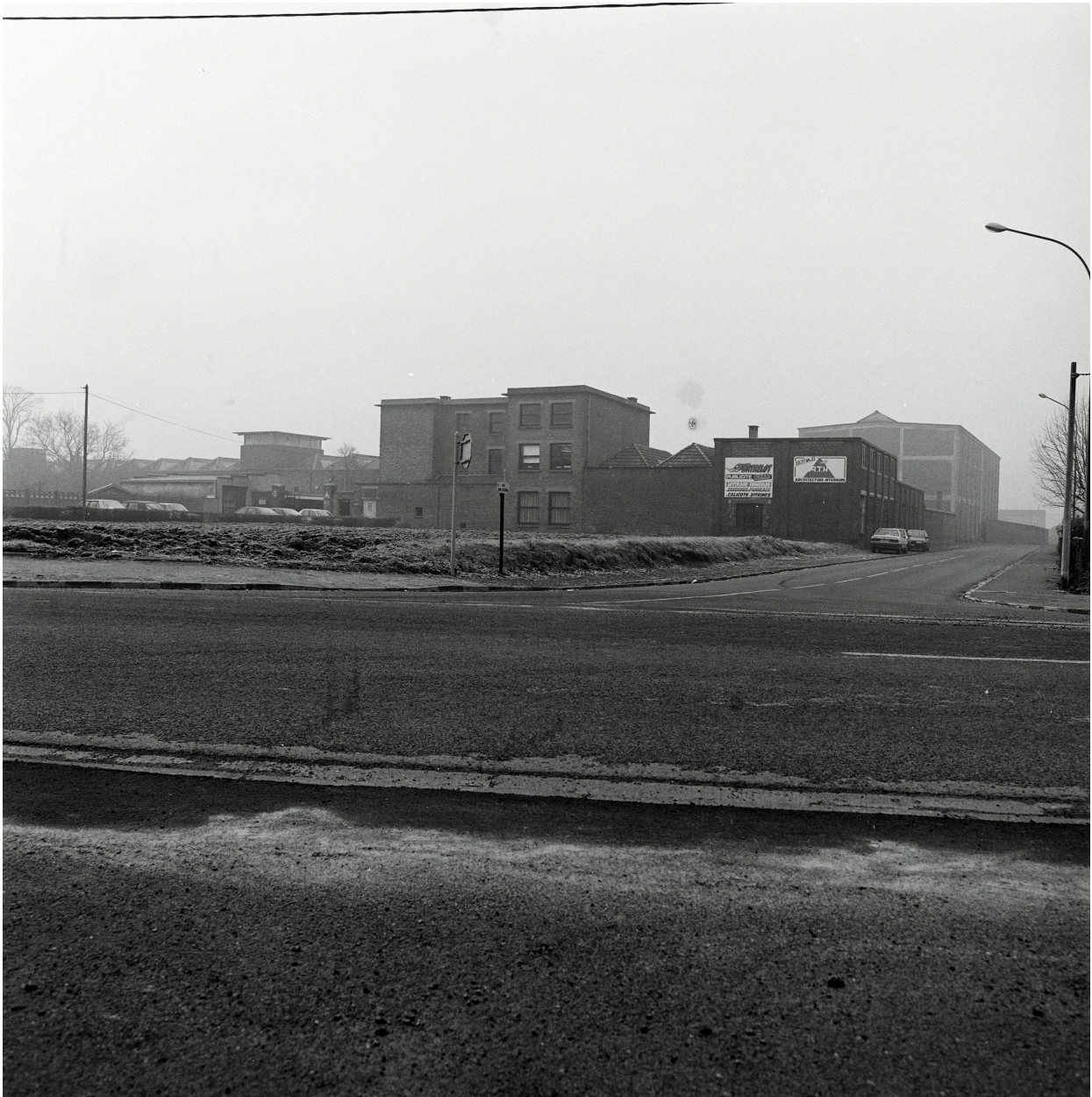
Vue générale prise vers le sud.
