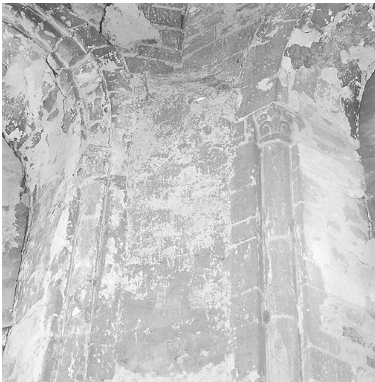
Bâtiment dans la cour, entrée 5 rue Henry, abside, angle est, chapiteaux.
