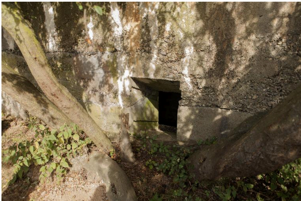
Ouverture dans l'élévation sud
