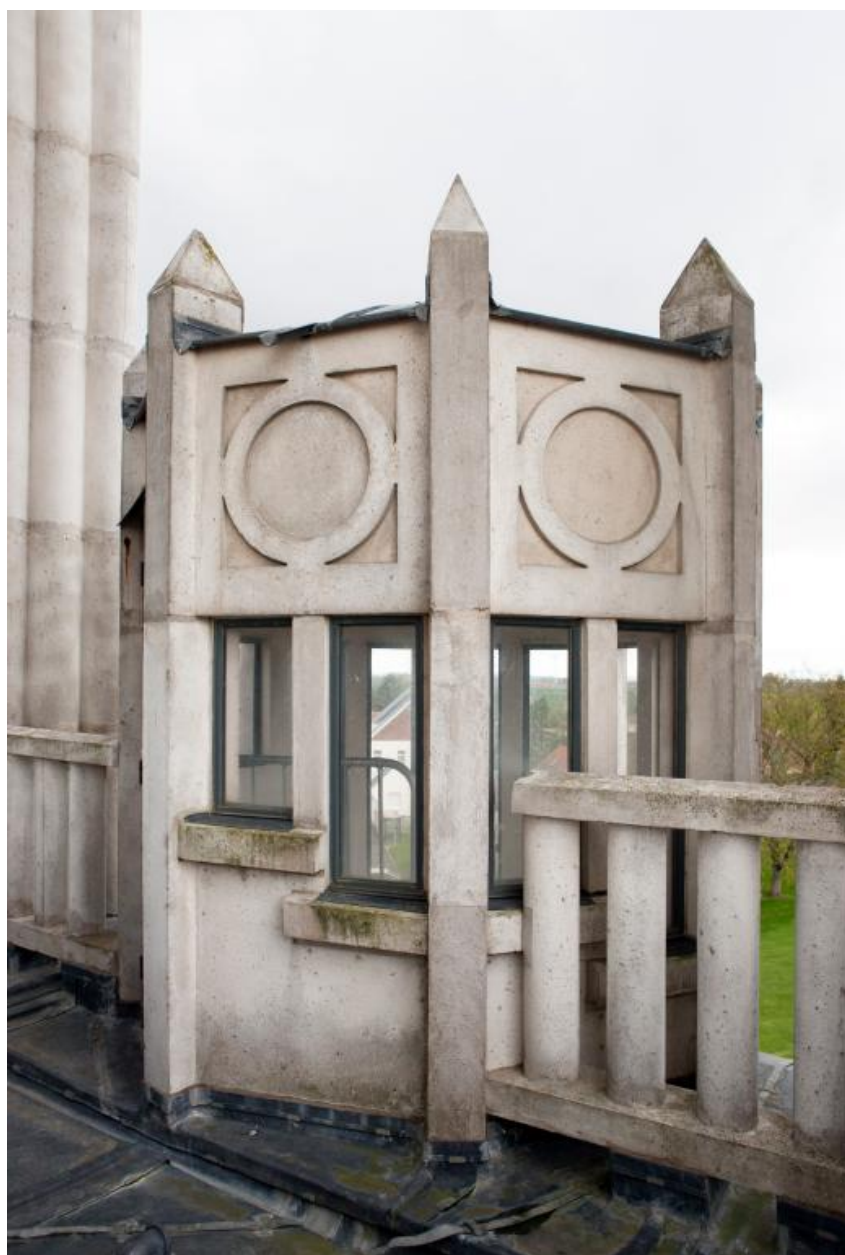
Lanterne de la tourelle d'escalier du clocher.
