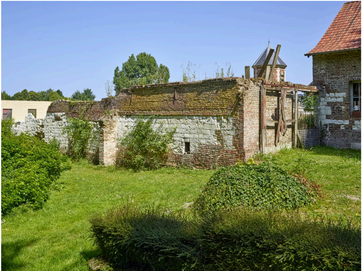
Mur de clôture ouest de la ferme et vue partielle du logement à droite.
