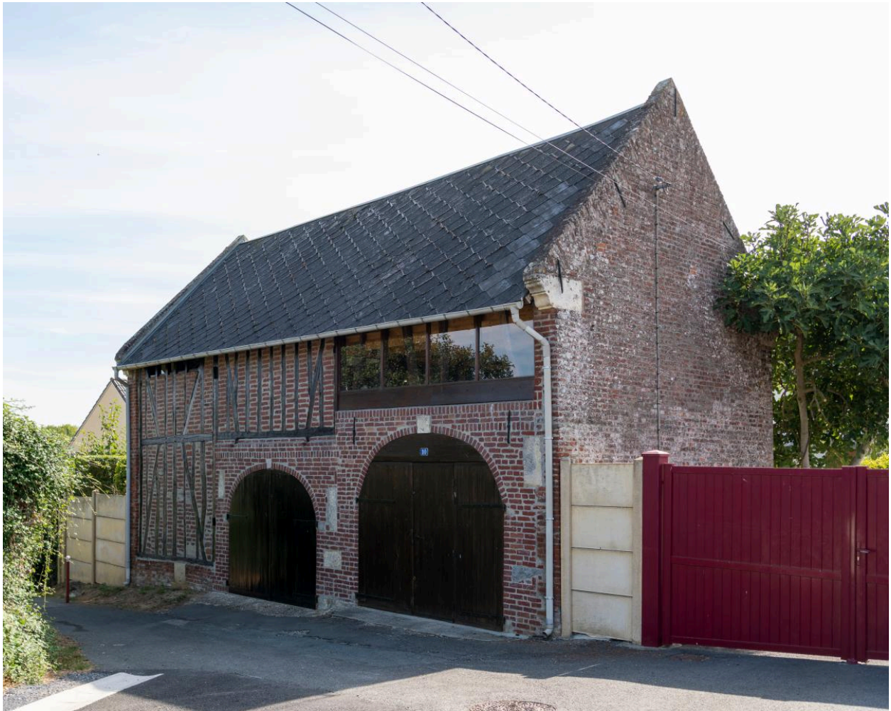
Ancienne grange remaniée, n°10 impasse Charles Mesnard, vue depuis l'ouest.
