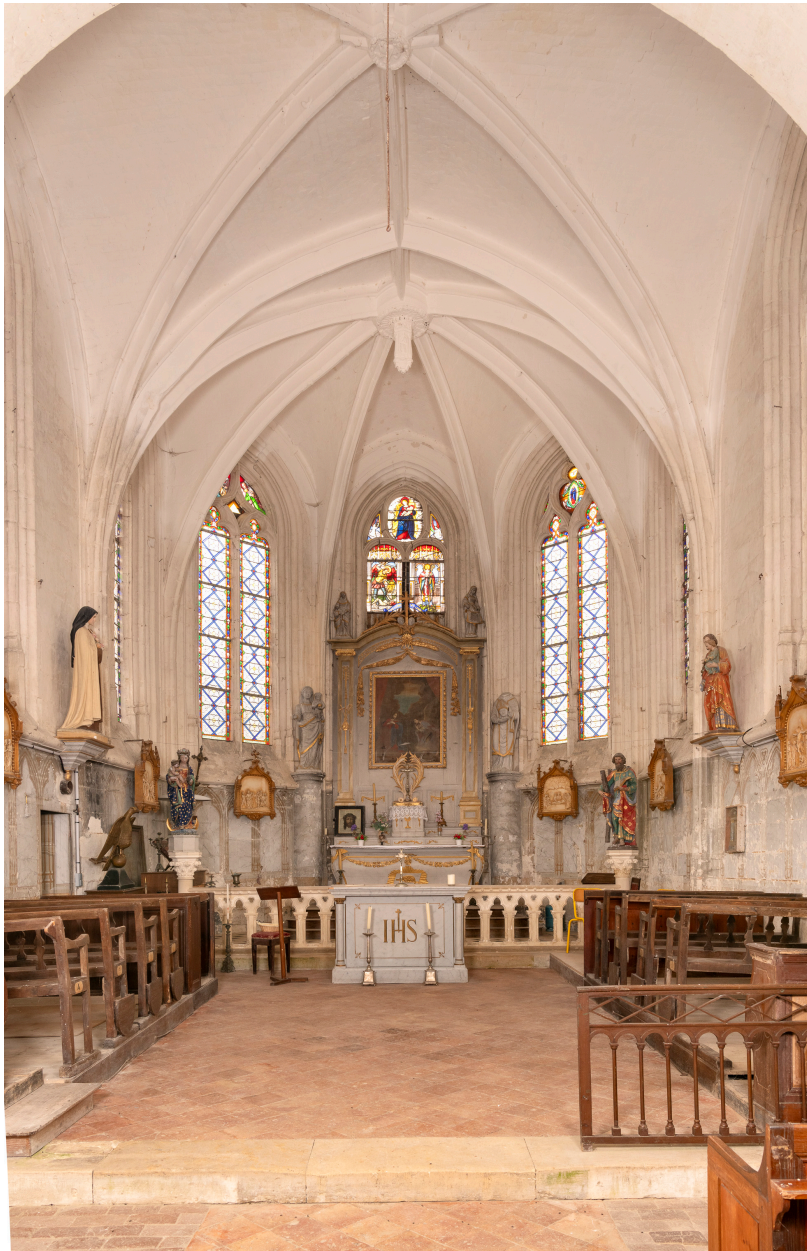
Vue générale du chœur.
