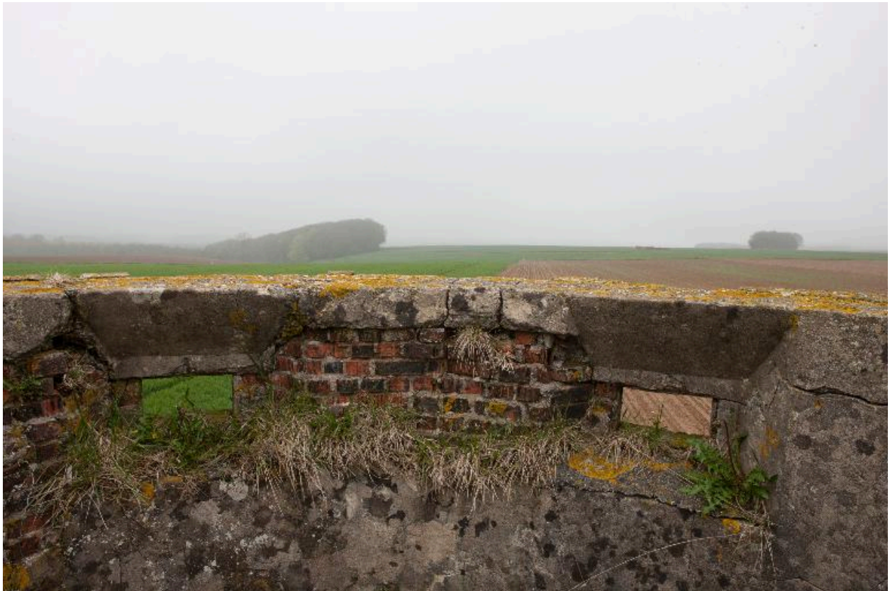
Vue du paysage depuis le dernier étage du poste d'observation.
