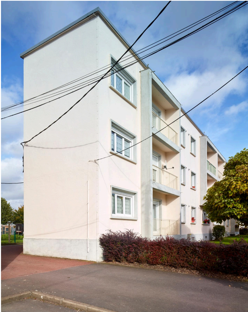
Vue du bloc A côté rue.
