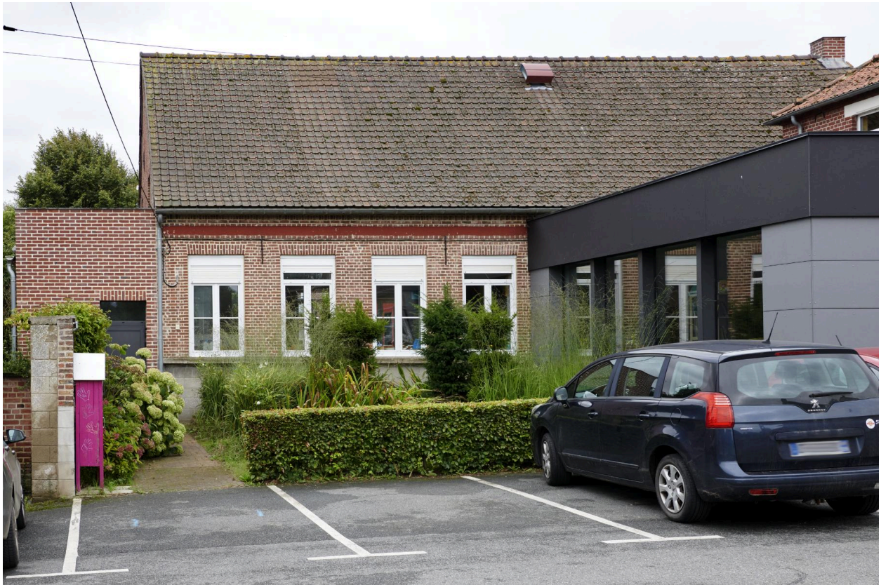
Vue partielle de la façade nord.
