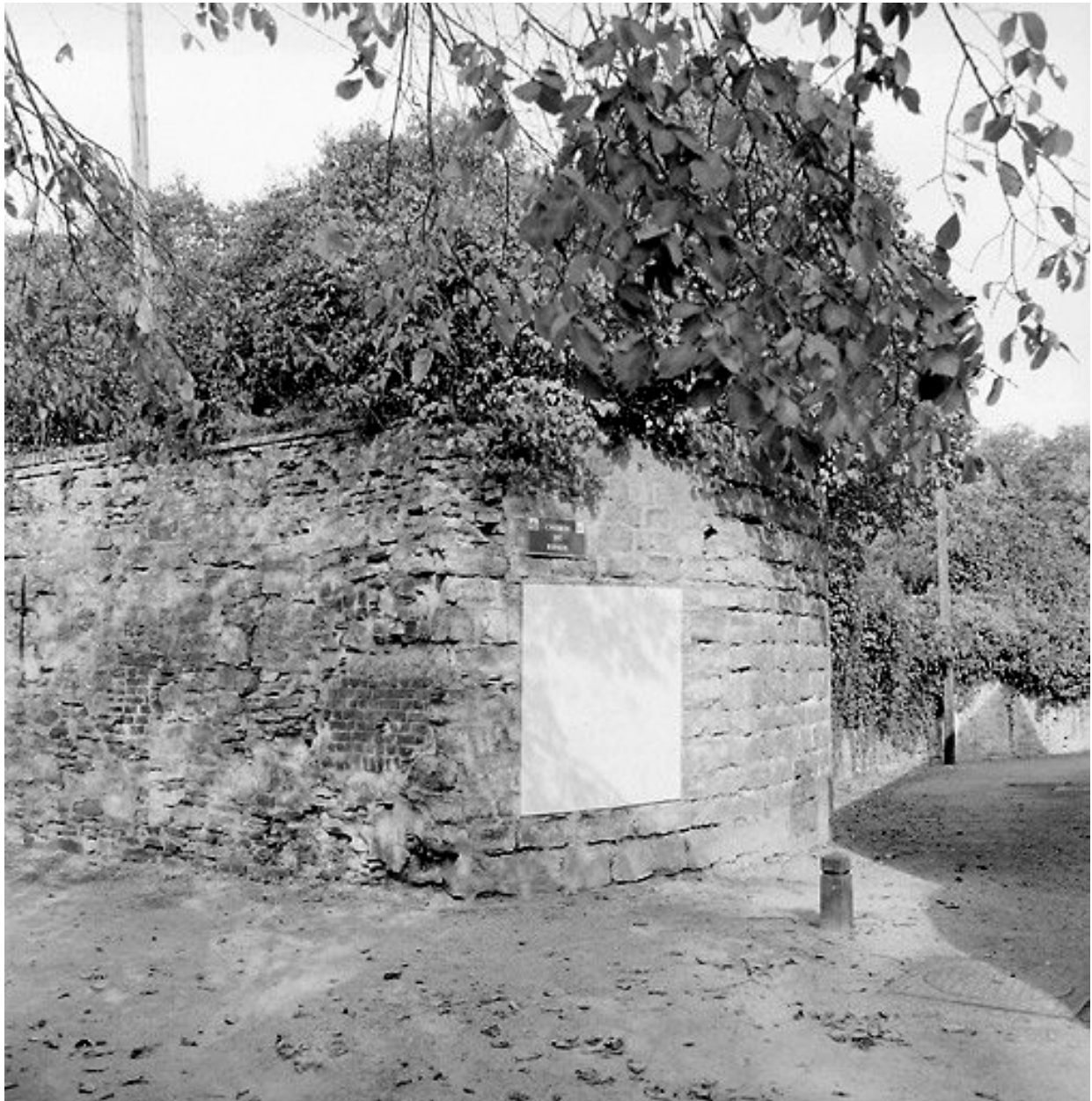
Tour placée sur l'angle sud-est, vue depuis le sud.
