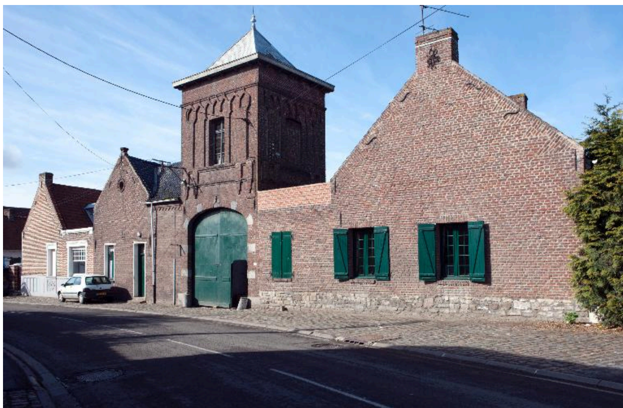
Vue générale de la ferme à cour fermée 14 et 14A rue Poincaré.
