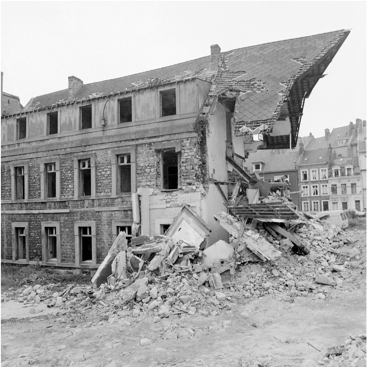
Bâtiment C, façade sur cour, partie nord.
