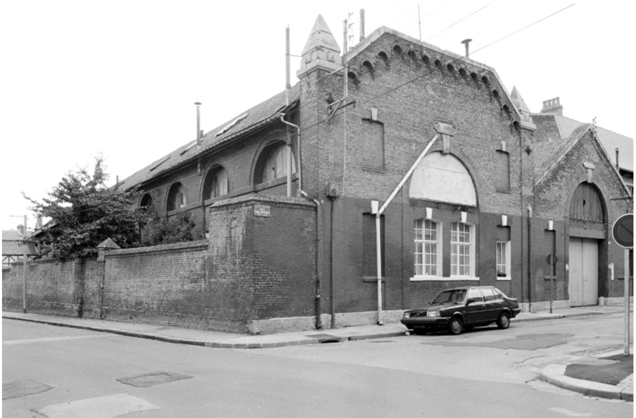
Vue générale depuis le sud.
