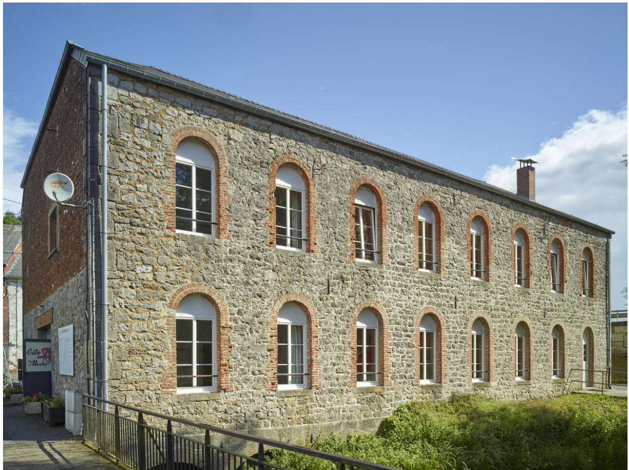
Le magasin à laines, élévation sur la rivière de l'Helpe-Mineure, vers le nord-est.
