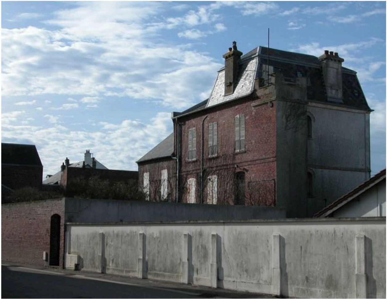
Elévation postérieure sur la rue Sainte-Catherine.
