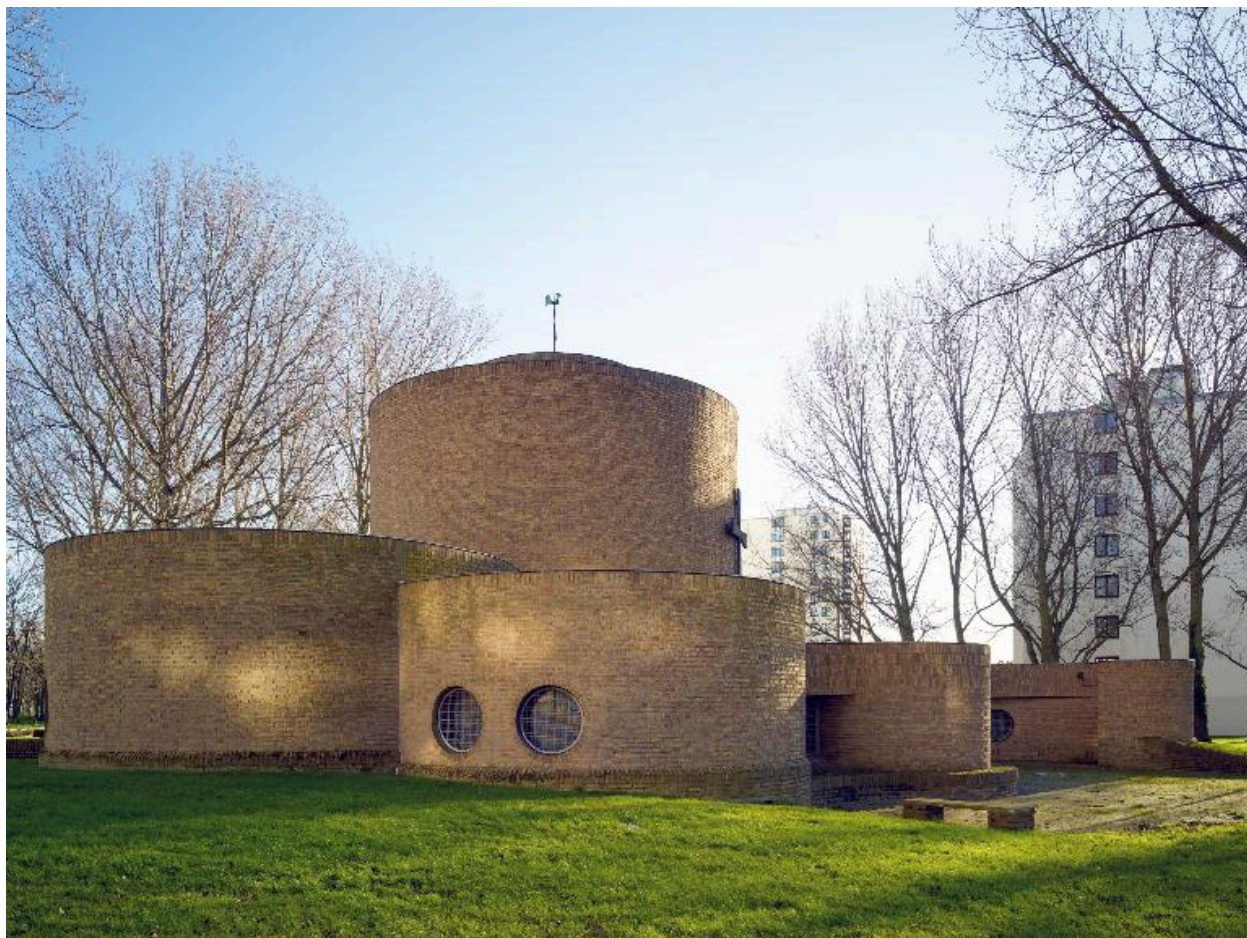
Élévation de la chapelle, côté nord ouest
